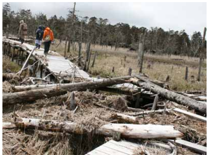
アカエゾマツコースの橋
