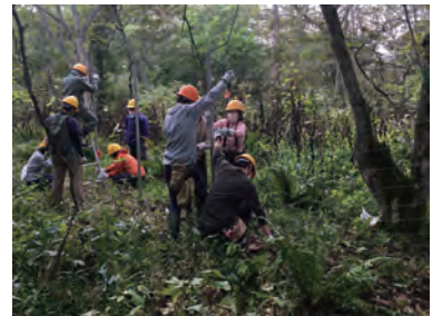
▲2022年度のシカ柵設置時の様子
